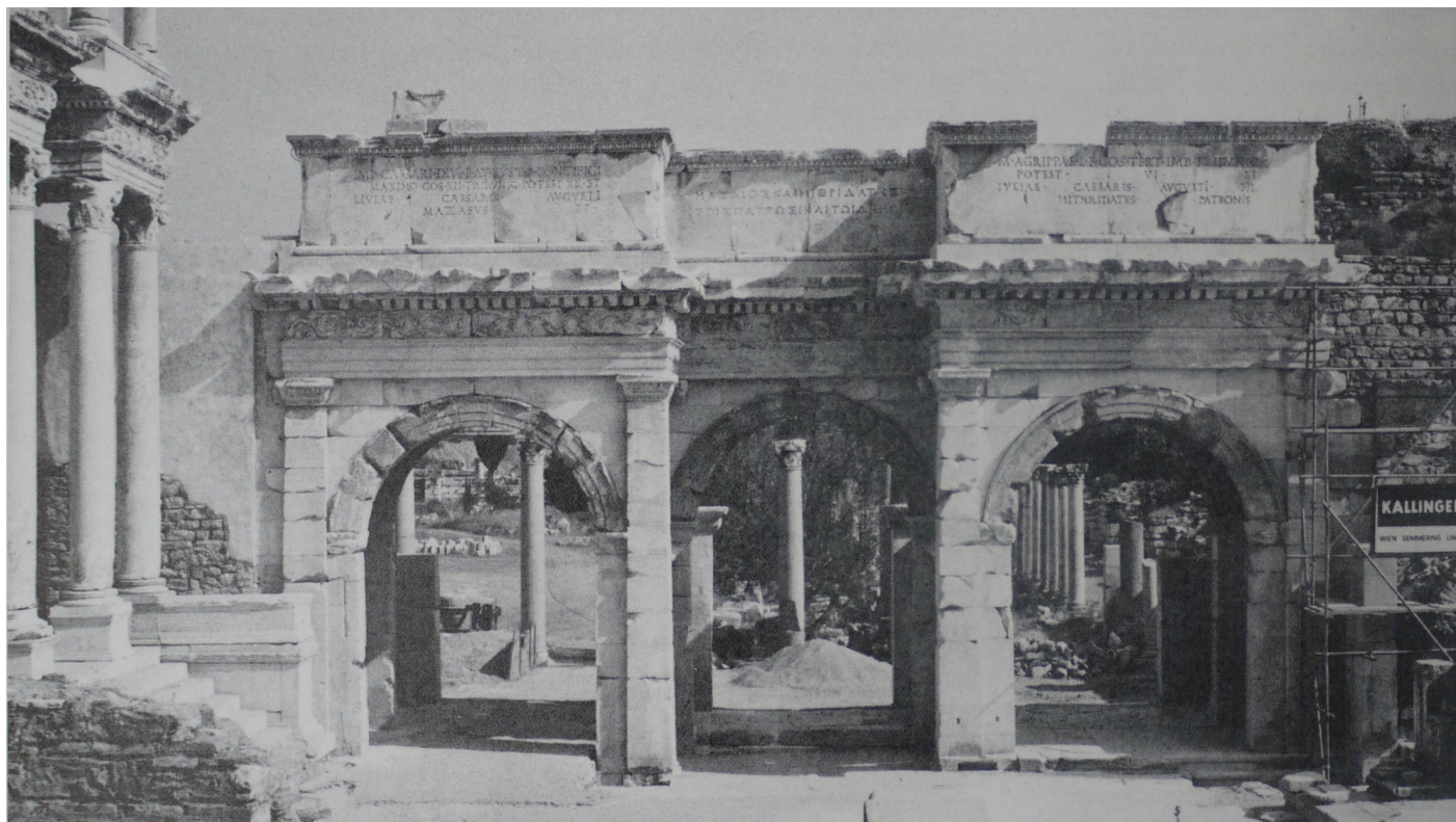
Fig. 6. Porte sud de l'agora, photo de la façade sud de la porte après reconstruction (1989). (Fr. Hueber 1989, p. 126 fig. 155).
