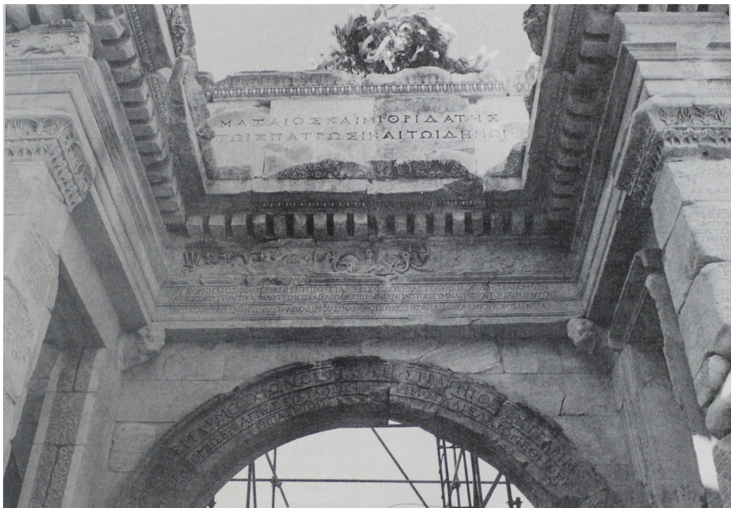
Fig. 15. Porte sud de l'agora, arc médian de la façade sud, vue de détail de l'anastylose.(F. Hueber 1989 fig. 157, p. 127).
