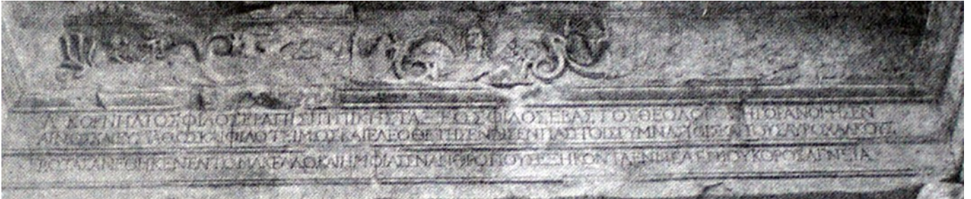
Fig. 18. Porte sud de l'agora, entablement central de la façade sud. M 61-I. Ephesos 3015 : façade S détail architrave et frise. (F. Hueber 1989 fig. 157 p. 127).
