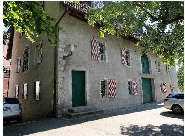
Figure 2 Bâtiment accueillant les réserves du MAZ © HE-Arc CR, Gaëtan Guillod 2021
