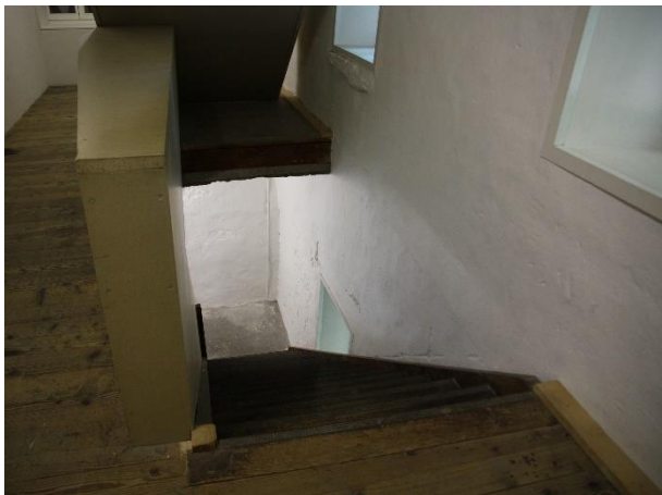
Figure 13 Escalier menant au 2 ème étage © He-Arc CR, Gaëtan Guillod, 2022.
