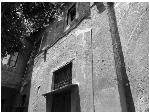
fig. 319: Roma, S. Maria del Priorato, fronte del fabbricato addossato al fianco S/E della chiesa, con due ghiera delle arcate tamponate visibili al di sotto dell'intonaco (foto Pollio 2016)
