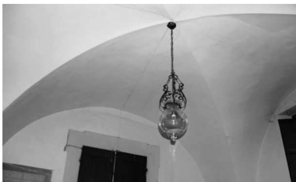
fig. 320: Roma, S. Maria del Priorato, volta a crociera della prima campata da N/E all'«interno» dell'ex portico (foto Pace 2017)
