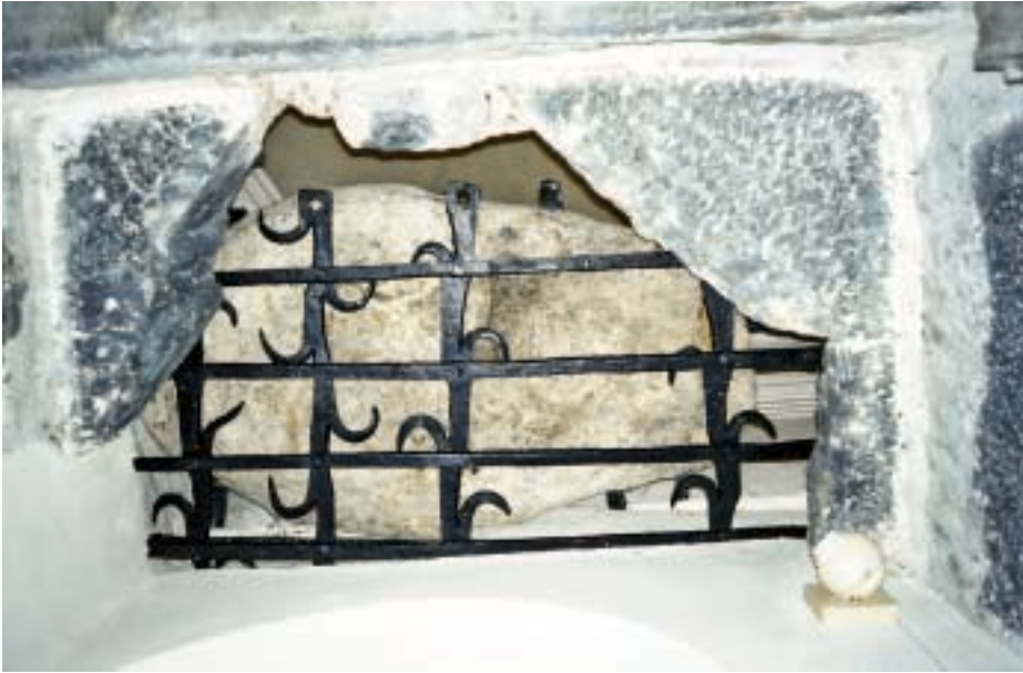
Abb. 3 : Untersicht der Aedicula mit Eisengitter und Richtstein.
