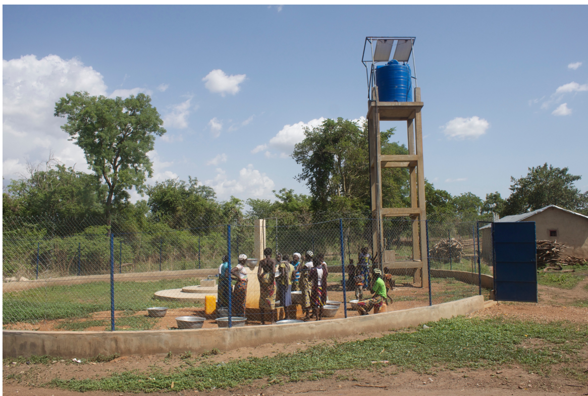
Photo 5 : Forage à énergie solaire du projet QualiEau à Sonri (Nikki, 25.05.15, MAV)
