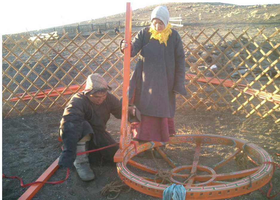
Figure 16 : Scène de montage de la yourte. Après la réunification des pans de treillis de bois entre eux, Jagaa passe à la fixation des deux poteaux sur la couronne, destinées à recevoir les perches de la toiture. Bayantsagaan, novembre 2006, A. Amarsanaa.
