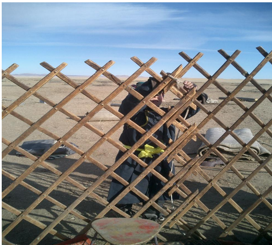
Figure 17 : Etape de montage de la yourte : Nomuun, en train de lier les pans de treillis de bois entre eux, appelés « murs ». Bayantsagaan, octobre 2006, A. Amarsanaa.
