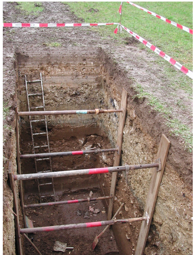
Fig. 7.7 Sondage profond étayé à Chevenez, Combe Ronde (S2 2696, novembre 2002). Les pierres qui apparaissent en fond de fouille, dans le coin du sondage, correspondent à un foyer d'âge protohistorique, situé à 4 m de profondeur.
